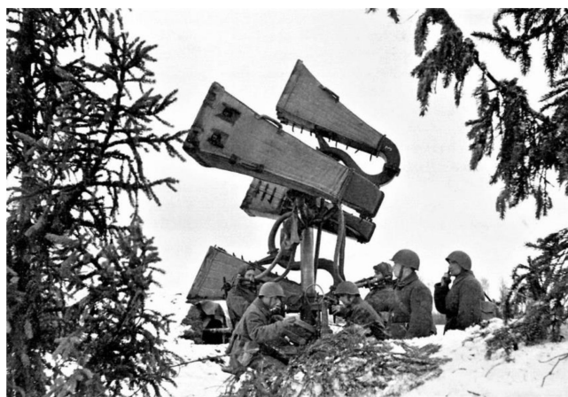
Рис. 12. Советский звукоулавливатель ЗТ-5 (1941 г.). Во время войны усовершенствован Юрием Михайловичем Сухаревским и Дмитрием Ивановичем Блохиным.
