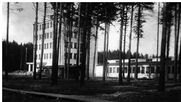
Первое здание Уральского физико-технического института, 1935 г. Здесь была смонтирована центрифуга Ланге.
