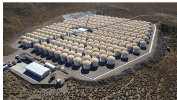
Рис. 4. Установка HAWC около Пуэбло в Мексике на высоте 4100 м над уровнем моря (вулкан Сьерра-Негра). Отдельные детекторы представляют собой баки с водой для регистрации черенковского излучения частиц ШАЛ. В сущности, это реализация идеи Коккони 1959 года [4].
