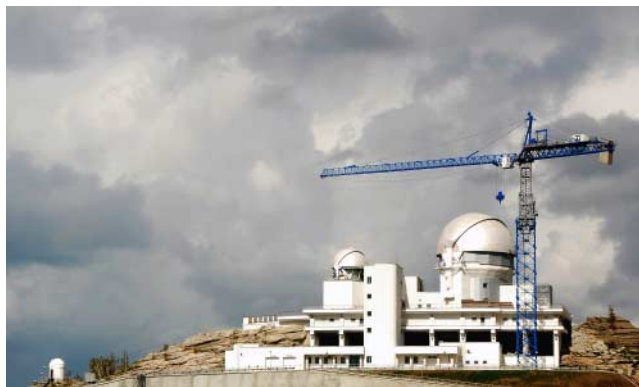
Рис. 10. Общий вид строительства второй очереди Алтайского оптико-лазерного центра с телескопом ТИ (телескоп информационный) с диаметром зеркала 3,12 м.
