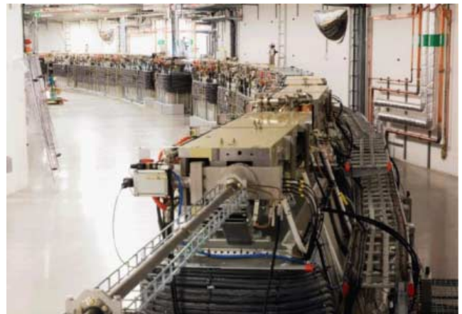
Рис. 17. Накопитель MAX IV. Видна последовательность идентичных магнитных блоков. На переднем плане — малоапертурная вакуумная камера прямолинейного промежутка.
