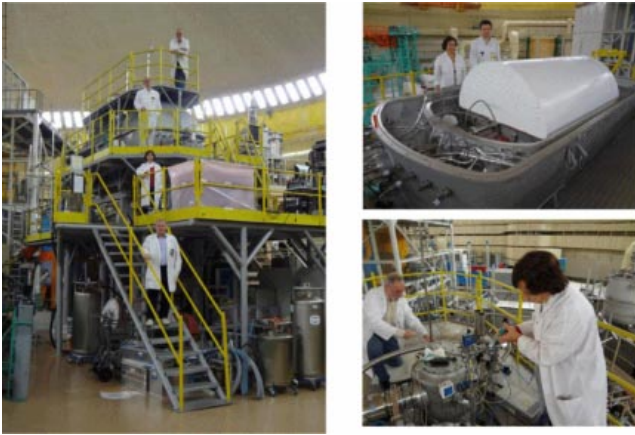
Рис. 18. Завершение монтажа большой гравитационной ловушки.
