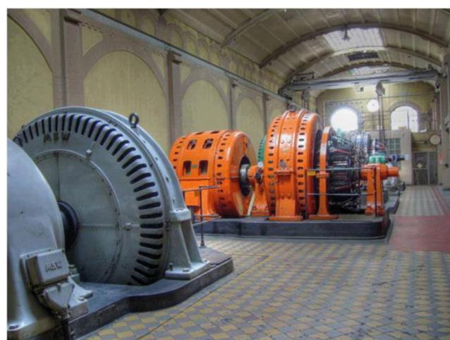
Рис. 2. Зал моторов-генераторов для питания биттеровских соленоидов в старом здании МЛ (современный вид).
