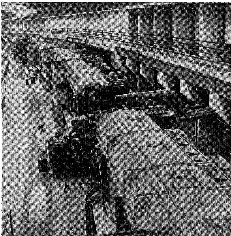
Рис. 5. Часть кольцевого электромагнита ускорителя ИФВЭ
