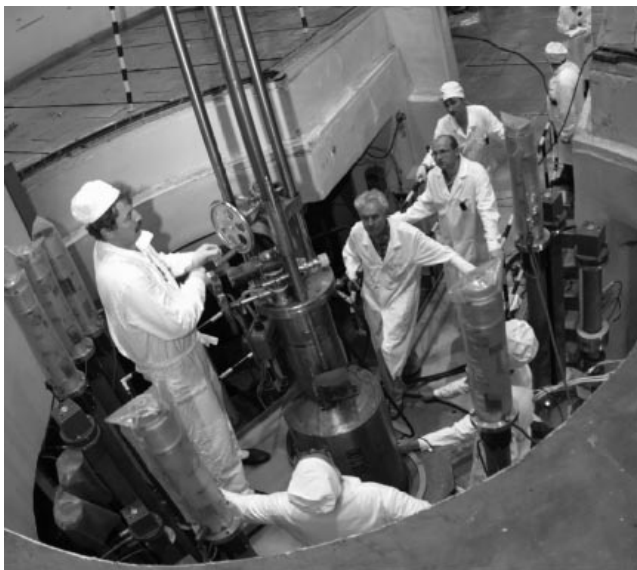
Активная зона ИБР-2, представляющая собой бак ёмкостью 22 л, в который помещается топливо — двуокись плутония. Бак загружается в корпус реактора.
