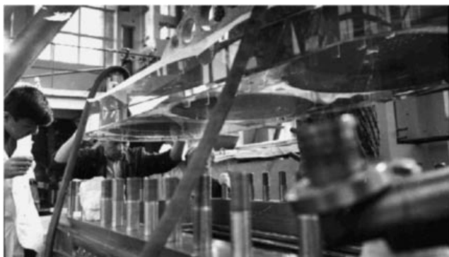
Водородная пузырьковая камера 2 м на сборочном стенде.
