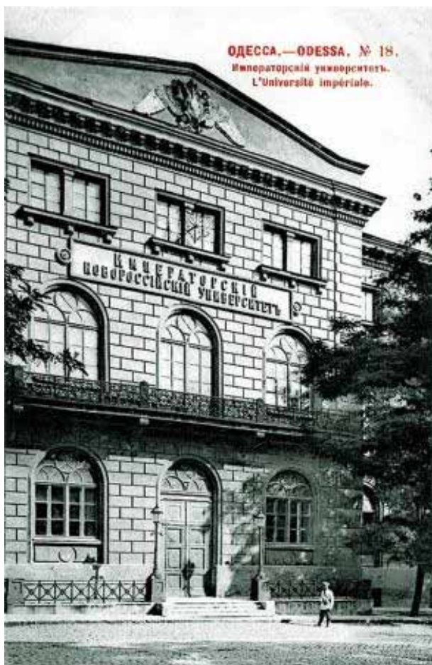
Парадный вход в главное здание Императорского Новороссийского университета (г. Одесса). В этом университете 22 года (с 1871 года по 1893 год) работал Николай Алексеевич Умов.
