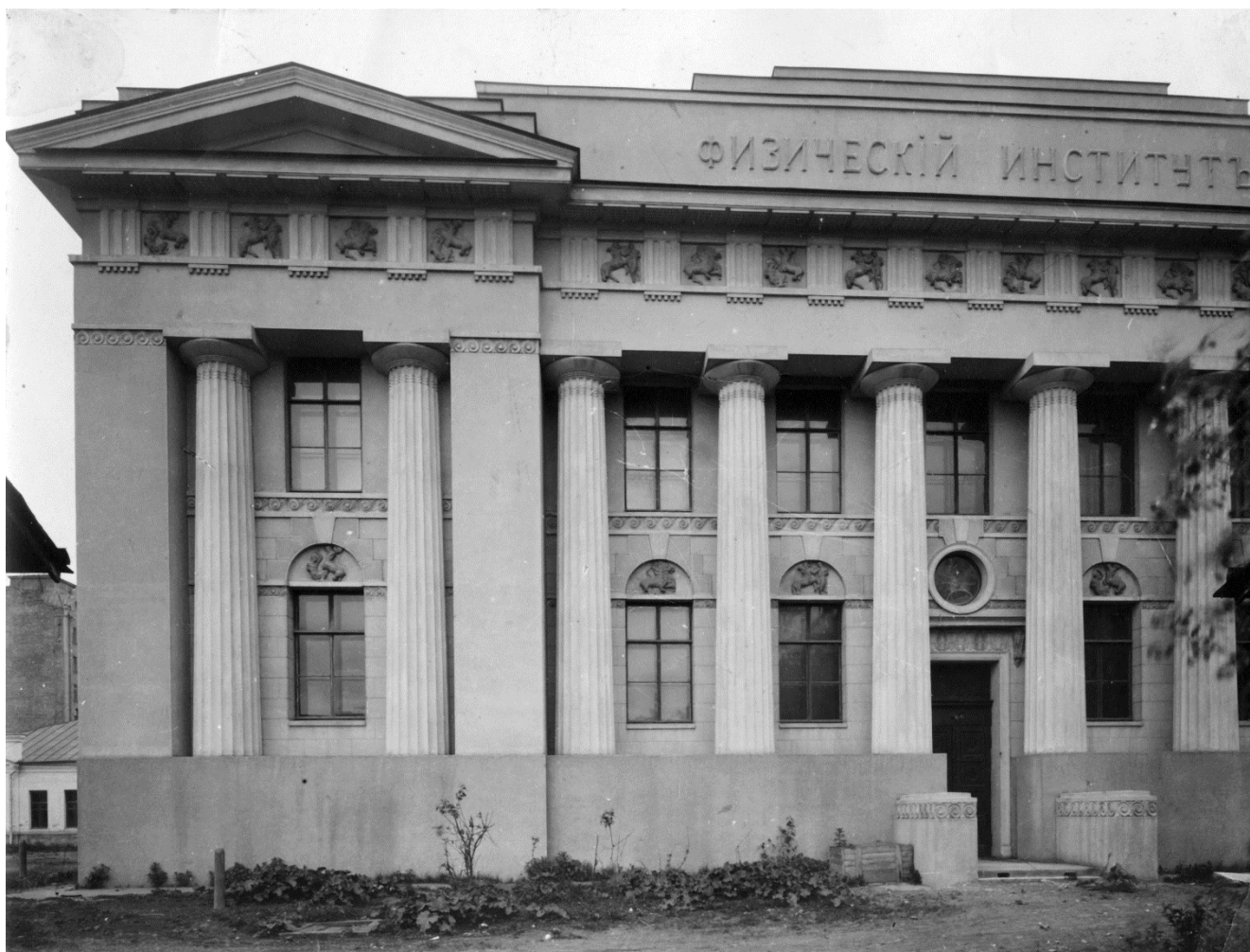
Рис. 3. Часть фасада Физического института Московского научного института в 1918 г.
